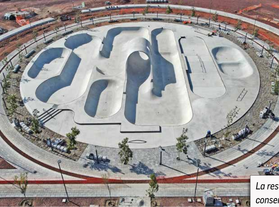
Diferentes aspectos de la infraestructura que se construye en el Proyecto Ecológico Lago de Texcoco. Fotos cortesía del PELT
