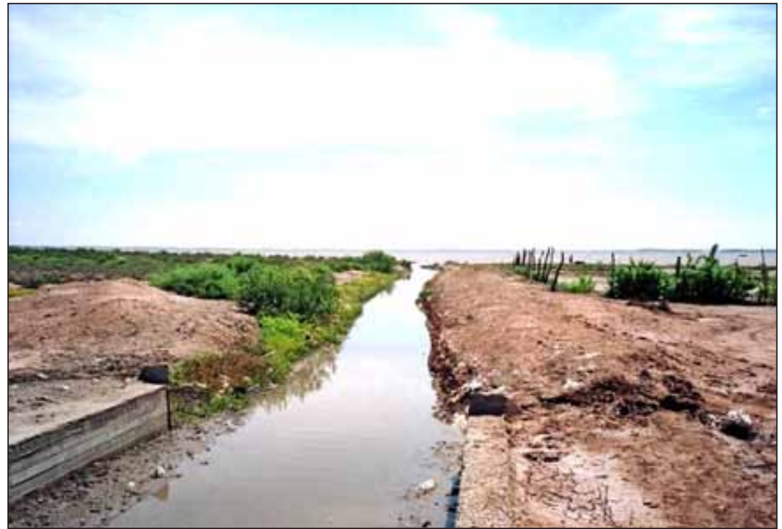
Dren agrícola descargando aguas residuales en la bahía del Tóbari. Milton Gabriel Hernández García
