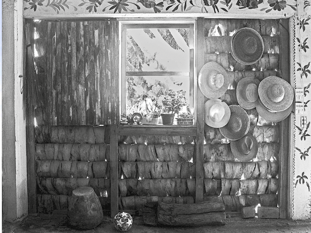
Pared construida con pencas de maguey en la cocina de Porfiria Rodríguez Cadena. Santiago de Anaya, Hidalgo, 2024. Foto: Justine Monter Cid
