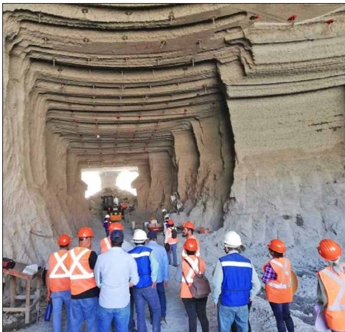
Ventana de la presa. José Ramón Carmona
