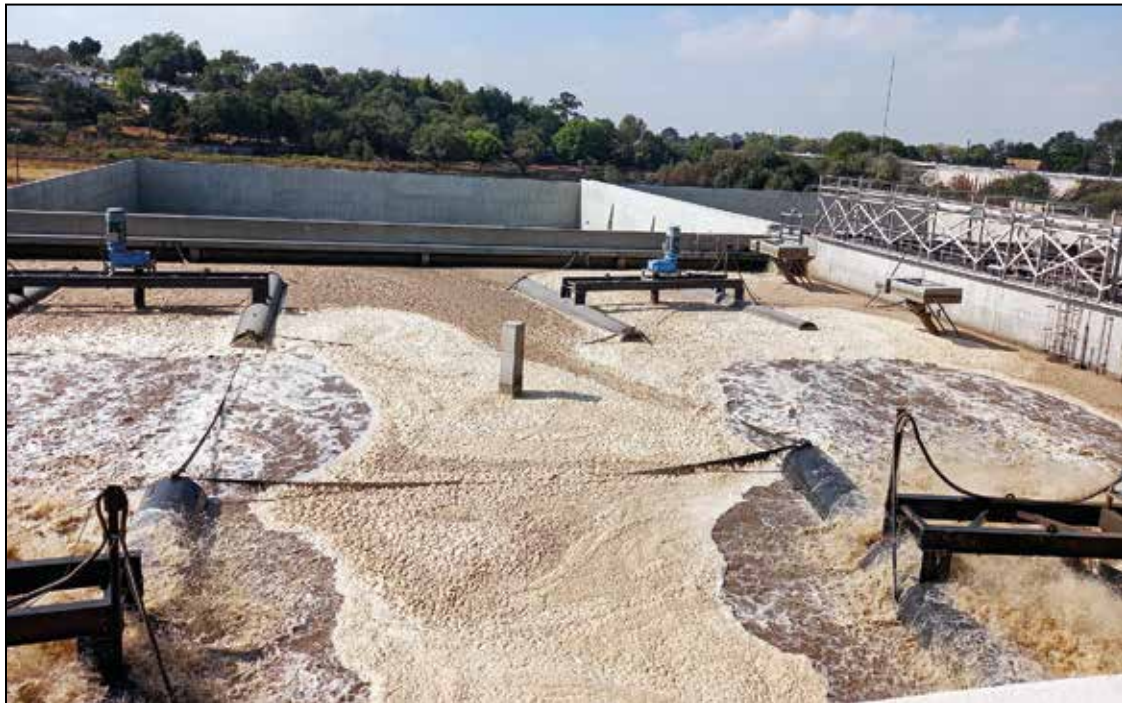
Aspecto de la planta de tratamiento de aguas residuales del municipio de Tlaxcala, donde se ubican las oficinas de la CEAS
