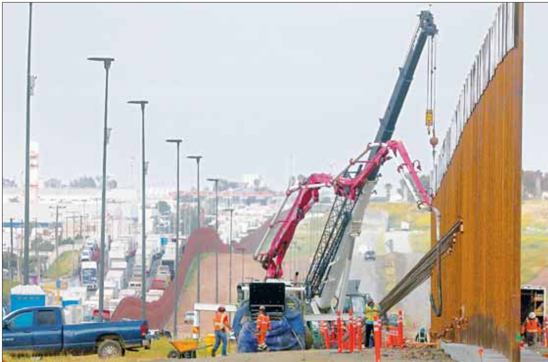
▲ La construcción de un segundo muro del lado estadounidense continúa en los límites con la Mesa de Otay, en Tijuana. A la izquierda de la imagen se aprecian las enormes filas de vehículos, sobre todo de
