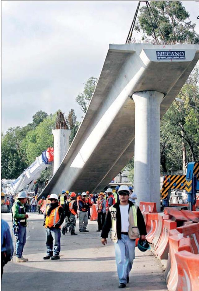
La deficiente colocación de una *ballena* de 20 metros de largo por tres de ancho, con peso de 280 toneladas, provocó que dos travesaños no la soportaran y se vinieran abajo en las obras del segundo piso que correrá por el Periférico, a la altura de avenida del Conscripto. Una grúa que participó en las maniobras también resultó dañada ■ Foto Yazmin Ortega Cortés
